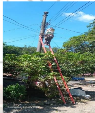
Reparación de cables y lámparas en área rural
