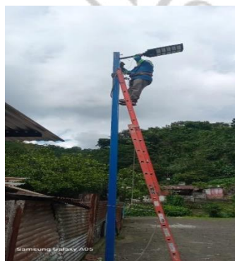
Colocación de lámparas solares
